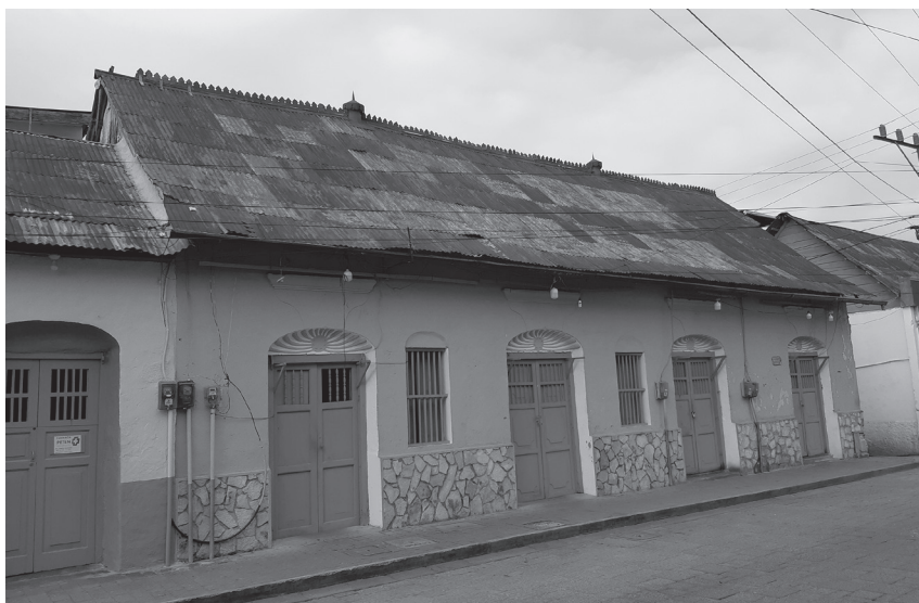
Figura 35. Vivienda tradicional, con los elementos característicos de la arquitectura doméstica floreña: dintel, arco rebajado, relieve de venera y decoración en madera sobre la viga madre.
