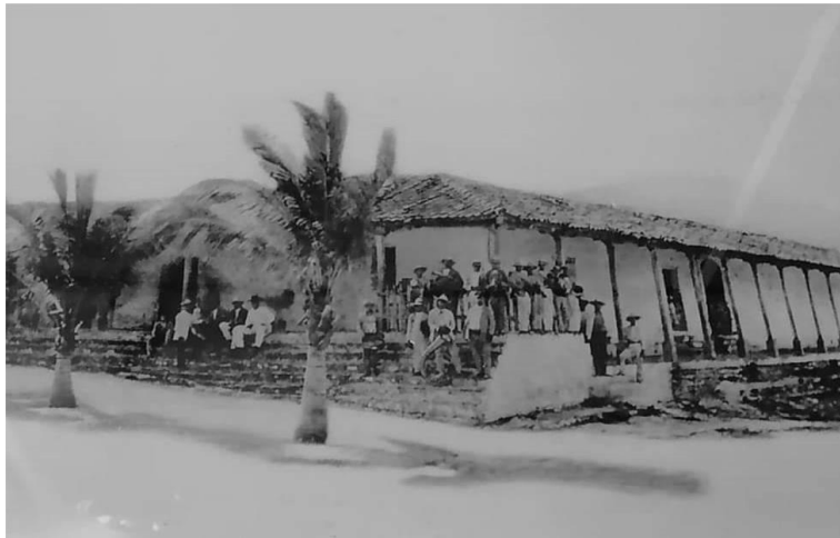
Fotografía del edificio antiguo del mercado municipal de Jocotán. Fuente: Caserío Los Hernández Taguayni (2021).
