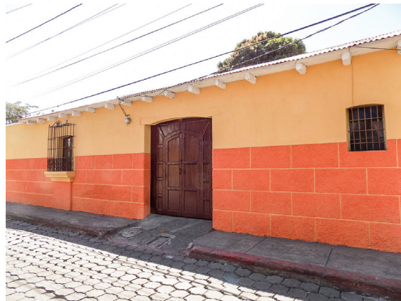
Figura 5. Liceo Colonial, fachada.
