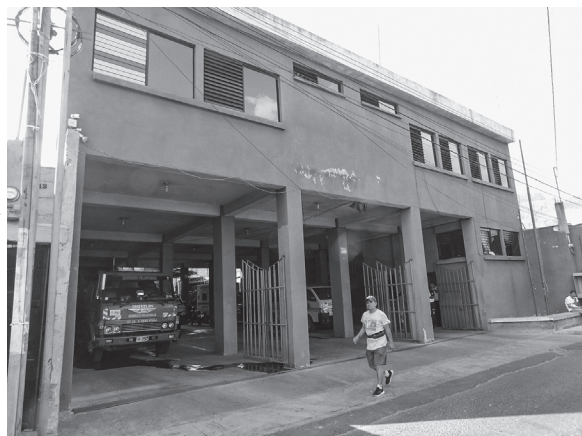
Figura 33. Estación de Bomberos, 1975.
