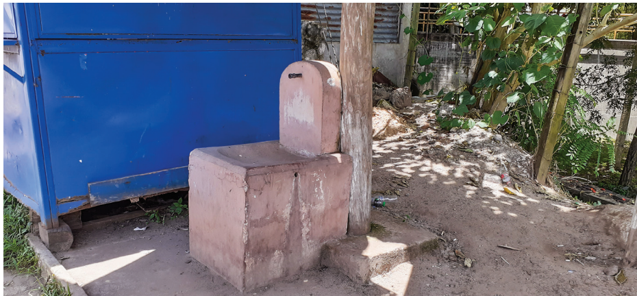
Figura 4. Estructura de un llena cántaros (ya no se utiliza) ubicado en uno de los costados del puente Los Esclavos. Abraham Solórzano
