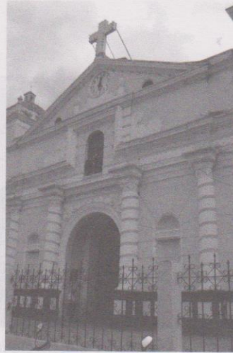
San Juan Amatitlán, Guatemala. Barroco: Fustes helicoidales, ruptura de línea horizontal en entablamento para ventana hornacina. Neoclásico: Decoración imitando sillares.
