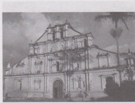
San Francisco Panajachel, Sololá. Manierismo: Hornacinas sin sillares, desproporción del tercer cuerpo, columnas sobre hornacinas, a partir de ménsulas, en el tercer cuerpo.
