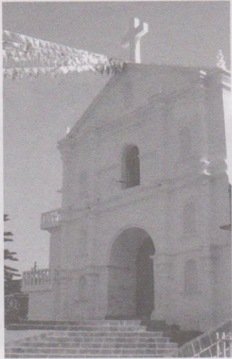
San Pedro La Laguna, Sololá. Barroco: Ruptura de la línea horizontal del primer cuerpo con la puerta de ingreso y en el tercer cuerpo con la ventana hornacina.
