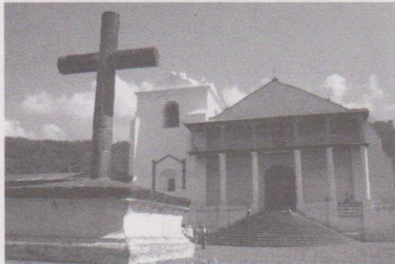
Santiago Atitlán, Sololá. Manierismo: Pórtico de dos niveles.
