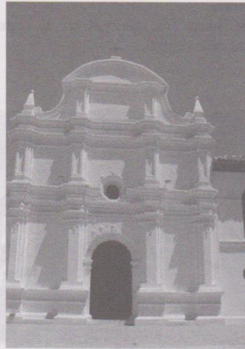
Santo Domingo Sacapulas, Quiché. Barroco: Movimiento de masa mural en columnas y entablamentos, ruptura de línea horizontal en entablamento primer cuerpo.
