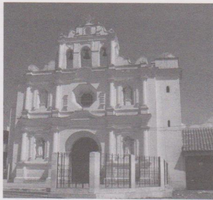
San Francisco El Alto, Totonicapán. Barroco: Movimiento de masa mural, frontones abiertos, ventana octogonal, frontón despuntado. Ultrabarroco: Pilastrillas almohadilladas.
