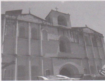
Santa Ana Huista, Huehuetenango. Manierismo: Cuerpos a desigual altura. Barroco: Ruptura de línea horizontal en ventana hornacina, ventana abocinada, movimiento de masa mural.
