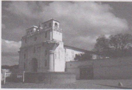
Santo Domingo Xenacoj, Sacatepéquez. Manierismo: Columnas colosales, hornacina en entablamento, ventana circular.
