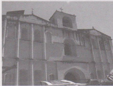
Santa Ana Huista, Huehuetenango. Manierismo: Cuerpos a desigual altura. Barroco: Ruptura de línea horizontal en ventana hornacina, ventana abocinada, movimiento de masa mural.
