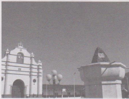
Santa María Cunén, Quiché. Manierismo: Cuatro entablamentos. Barroco: Ventanas octogonales. Neoclásico: Columnas toscanas.
