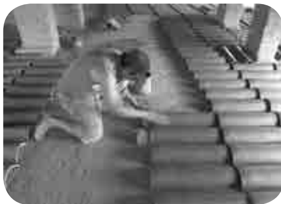
Don Froilán coloca tejas en la galera de tendido.
