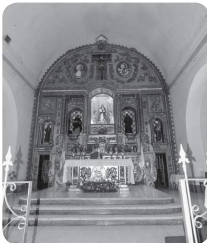
Presbiterio, con cubierta revestida de estuco y nuevo altar mayor, 2015.
