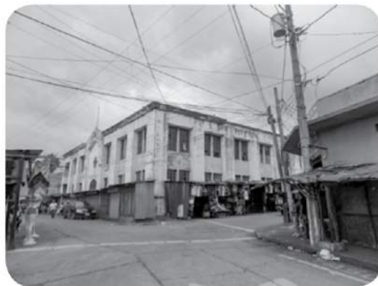
Mercado No. 2, construido en 2003.
