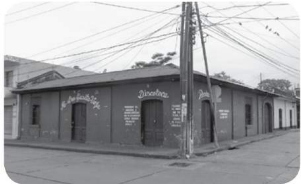
Casa tradicional, hacia 1890. Tuvo techo de teja, sustituido por cinc hacia 1919. San Sebastián.
