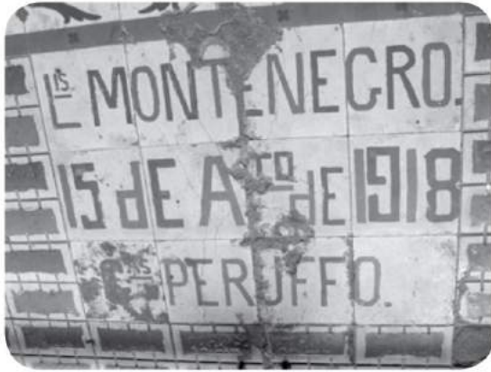
Inscripción del piso de cemento líquido, 1918, captada en 2010. Sustituido por piso cerámico.
