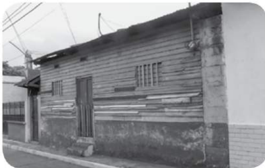
Vivienda con muro de mampostería y madera, similar a las casas de otras poblaciones de la costa sur.
