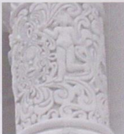
Putis en las columnas de la fachada Templo de La Merced, Santiago de Guatemala.
