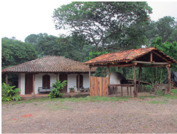
Figura 3. Instalaciones de la Molienda Don Nicolás. Fotografía: Sagastume García, diciembre 2016.
