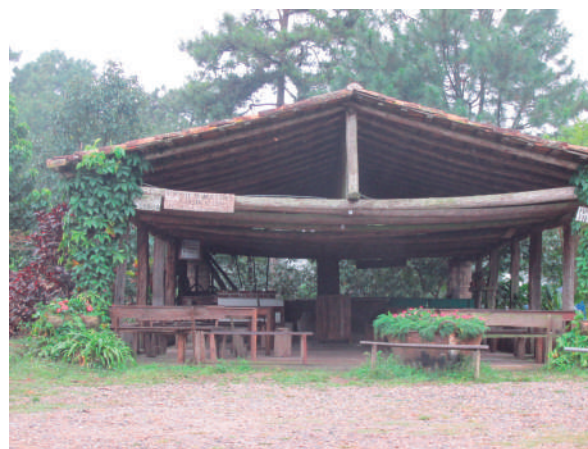
Figura 2. Instalaciones de la Molienda Don Nicolás. Fotografía: Sagastume García, diciembre 2016.
